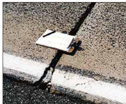
Фото 6. Уступы в швах (фотография сделана на дороге с левосторонним движением)
