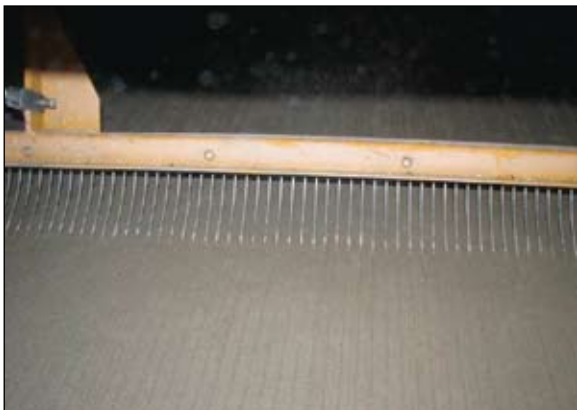
Рис. 5. Устройство для нанесения бороздок — стандартный способ, применяемый в шт. Вашингтон [10]: «вилы» из жесткой стали (tining) использовали раньше для поперечного боронования, а позднее — для продольного
