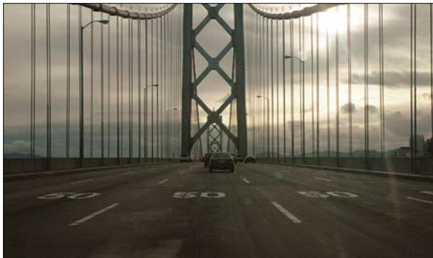
Рис. 2. Мост на маршруте Сан-Франциско — Окленд: Мост имеет два пролетных строения с проезжими частями по пять полос в каждом направлении
